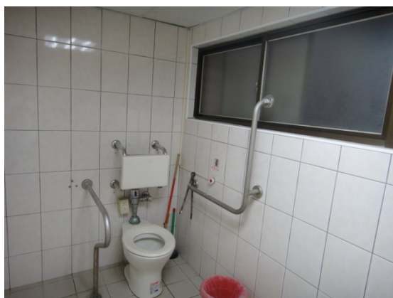
十五、和平大樓二樓女廁整修：
