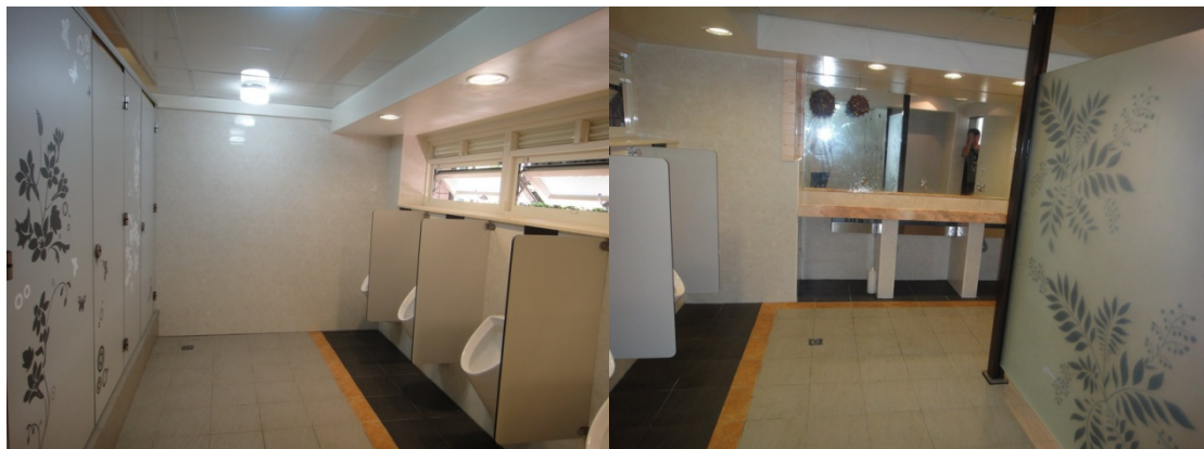
十四、和平大樓一樓無障礙廁所整修：
